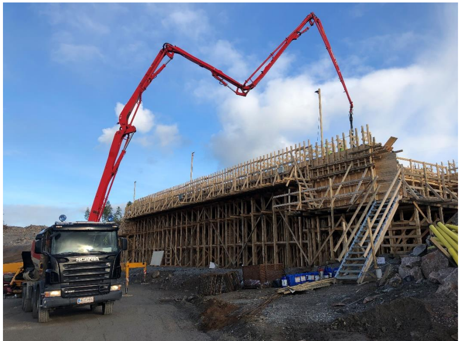
Kuva 2. Kuvassa on käynnissä sillan S1 kannen valu.
