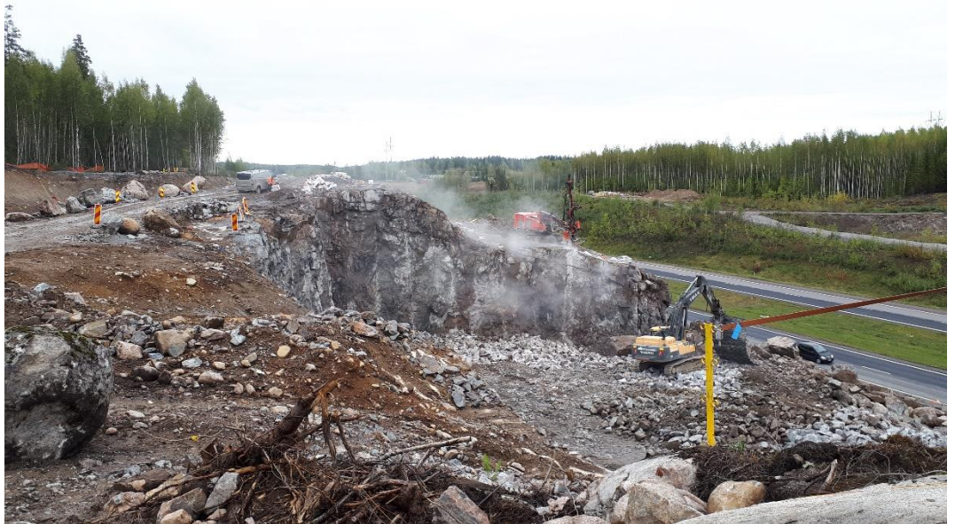
Kuva 3. Louhintatyöt jatkuvat Vt 3 reuna-alueilla. Kuva on otettu valtatie 3 länsipuolelta pohjoiseen katsottuna.
