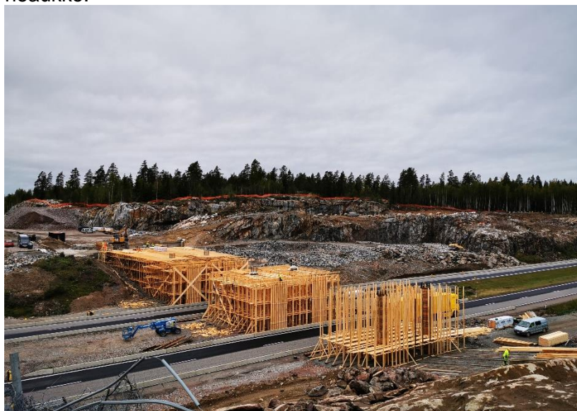
Kuva 1. Valtatie 3 ylittävä silta S5.
