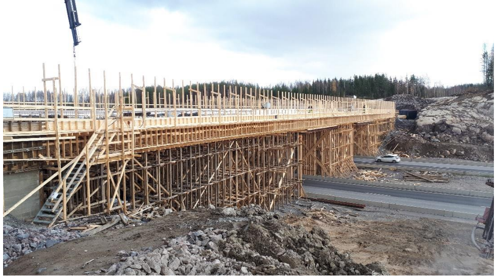
Kuva 1. Valtatien 3 ylittävä silta S5.
