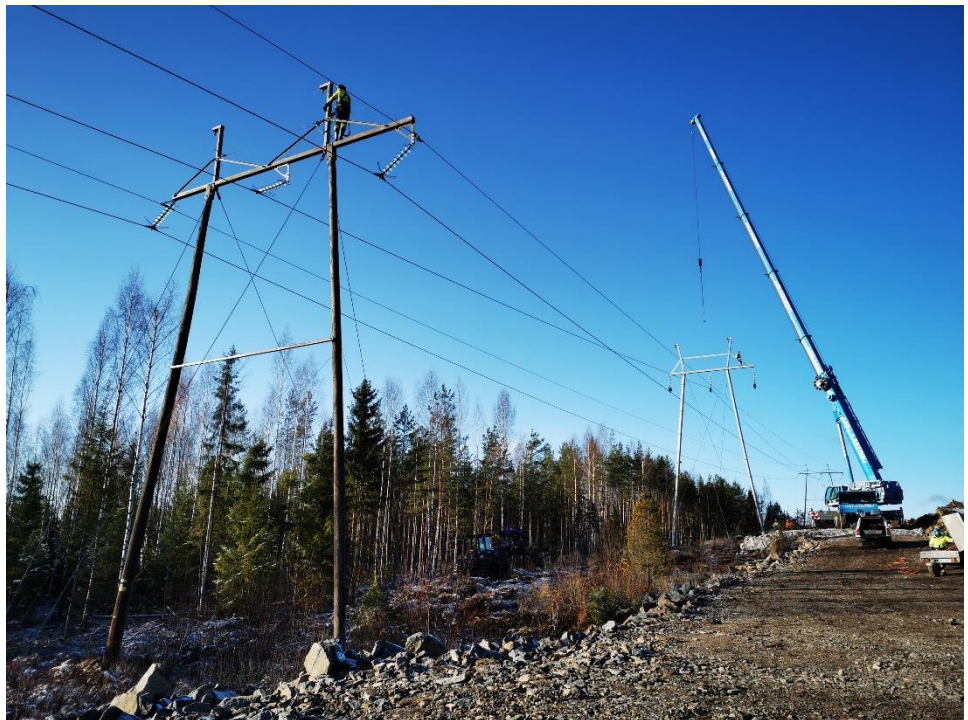
Kuva 3. 110 kV linjasiirtotyöt on käynnissä.
