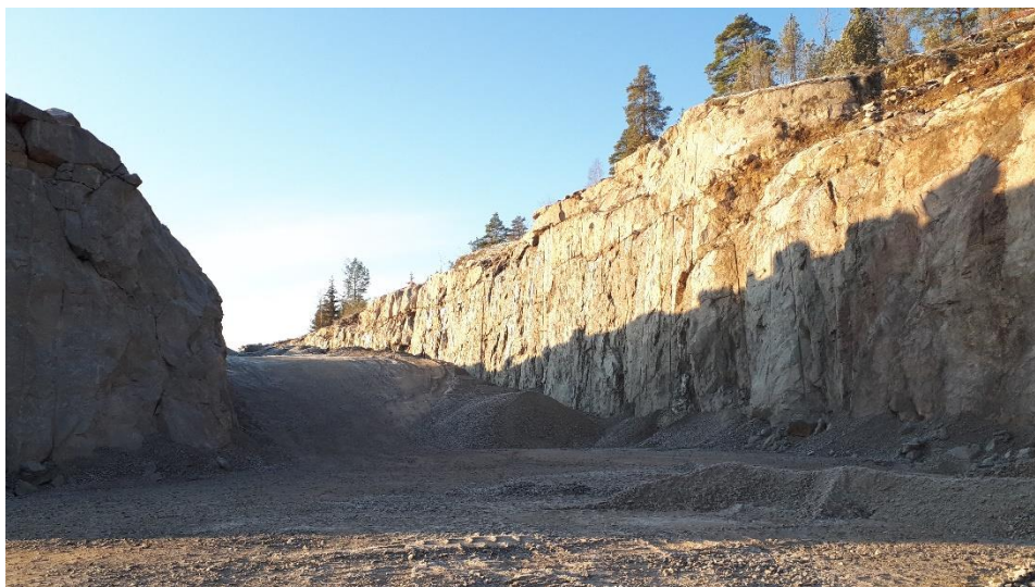
Kuva 4. Louhintatöiden ansioista valtatie 3 uudet rampit ovat valmistumassa.
