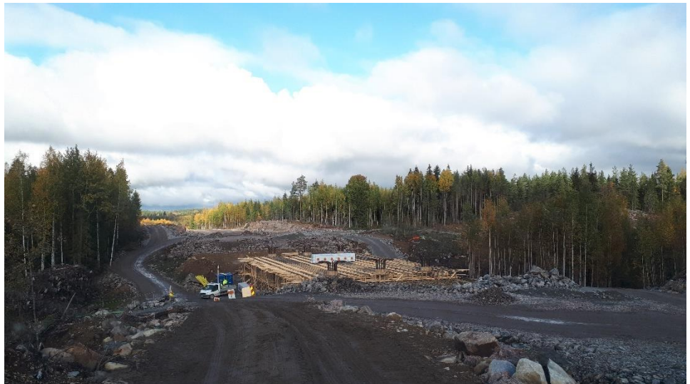
Kuva 2. Silta S2 Luhtajoen sillan rakentamistyöt on käynnissä.
