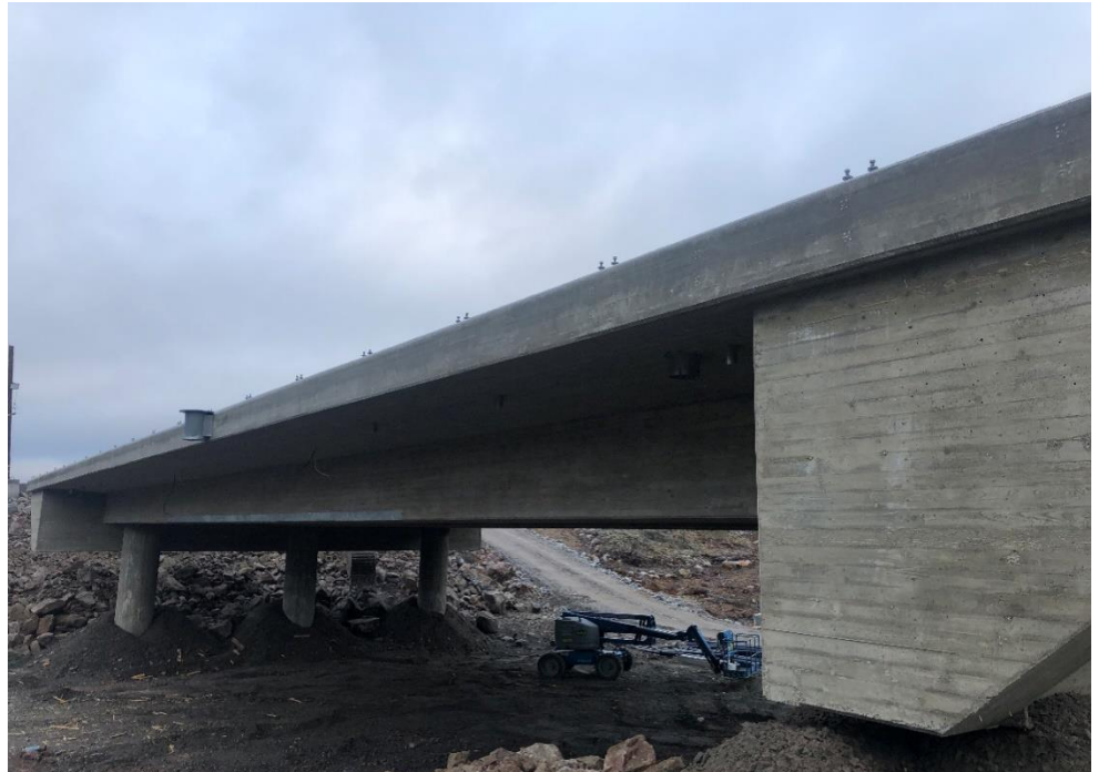
Kuva 1. Muotit ja telineet on purettu Luhtajoen risteyssillalta.
