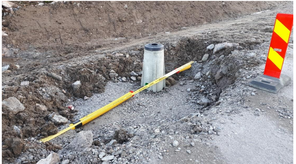
Kuva 3. Valaisinpylväiden jalustojen ja kaapelisuojarahputkien asennus on jatkunut työmaalla.
