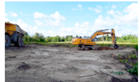
Porvoonjoen uoman siirron valmistelevat työt ovat käynnissä.
