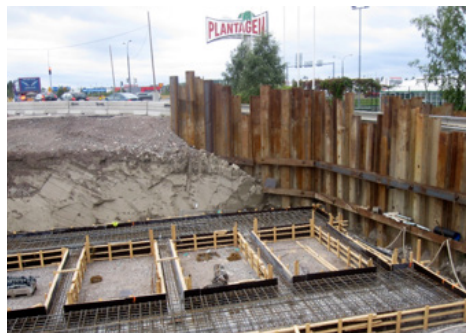
Kyöstilän alikulkukäytävän peruslaatan raudoitustyöt ovat valmistumassa.
