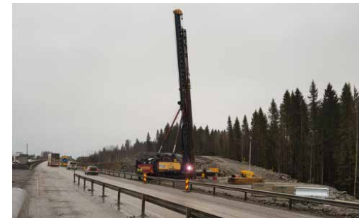
Kujalan risteysillan paalutus käynnissä valtatie 4 varrella
