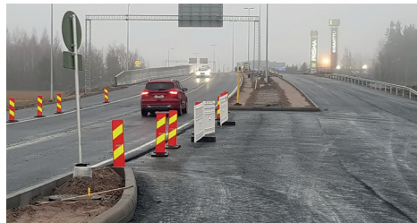
Launeen sillan länsireuna avattiin liikenteelle perjantaina 2.11.2018.
