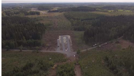
Kuvassa paalutuskoneelle tekeillä olevat työalustat Takamaalla.
