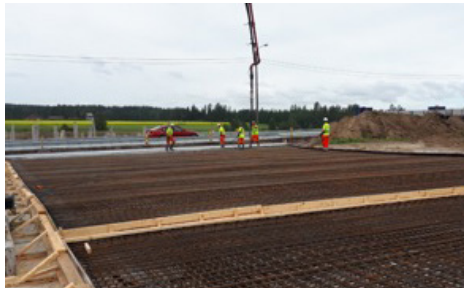
Kuvassa betonointityötä Okeroisissa.
