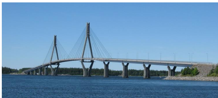
Bild 1 Replotbron är med sina 1 045 meter Finlands längsta bro idag.
