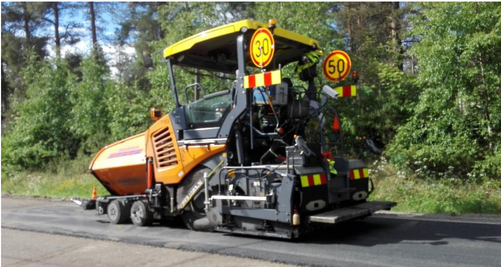
Kuva: Testiasennukset tehty Vögele 1803-3i-levittimeen
