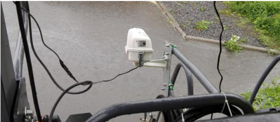
Kuva: Lämpökamera suojakotelointeen asennettuna levittimeen
