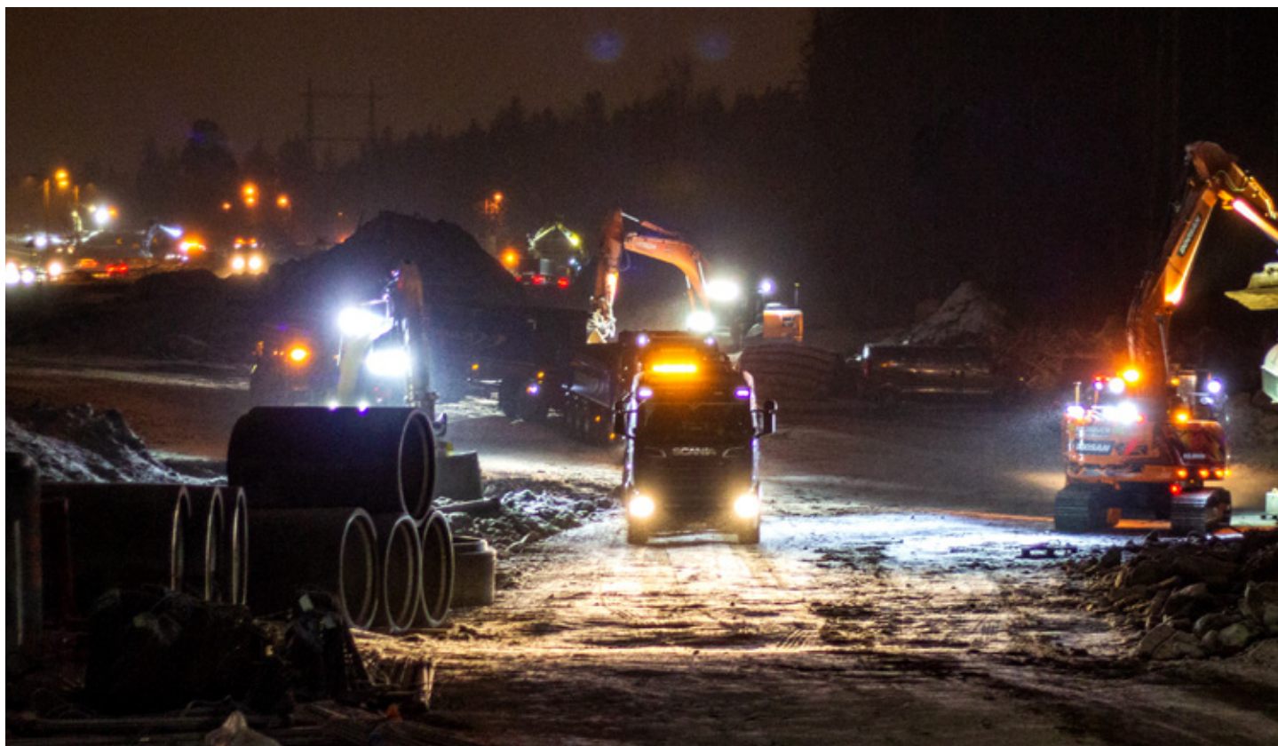
Rakennustöitä Sakkolantien ympäristössä
