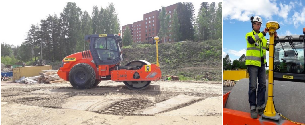
Kuva 2. Pilotissa käytettiin Hamm valssiyrää ja siihen asennettua Trimble CCS 900 tiivistystyön ohjausjärjestelmää.
