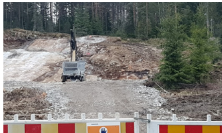
Ensimmäisen tutkimustunnelin työmaa Liipolassa.
