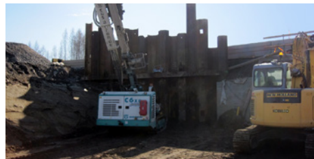
Kangasmäen alikulkukäytävällä tehtiin tukiseinää.
