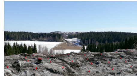
Kuvassa näkyy osa Patiokallion räjäytyskenttää sekä uutta tielinjaa idän suuntaan.
