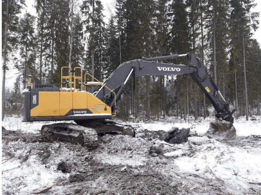
Kuva 1. Ensimmäinen kaivinkone aloitti työt ST-urakassa 12.2.2018.
