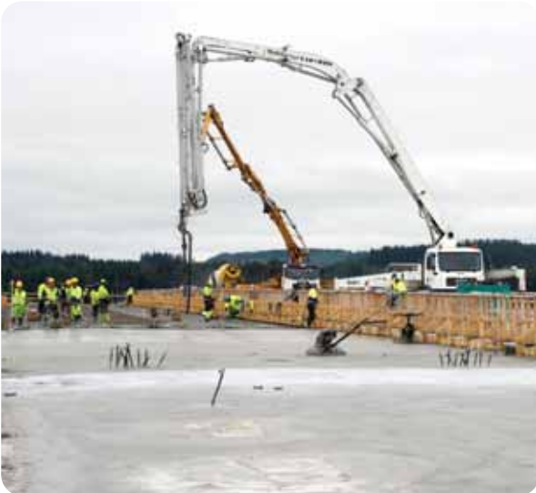
Siltakannen valua moottoritiesillalla
