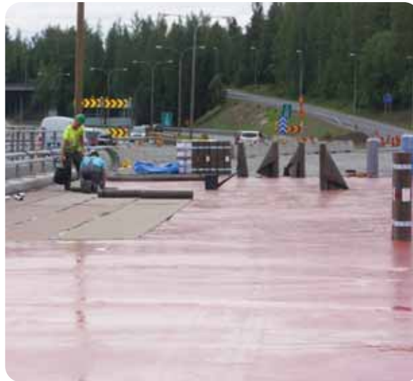
Eristystyötä läntisellä läppäsillalla S1
