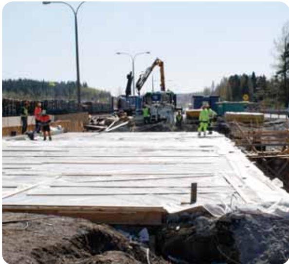
Virtasalmen sillan korjausta
