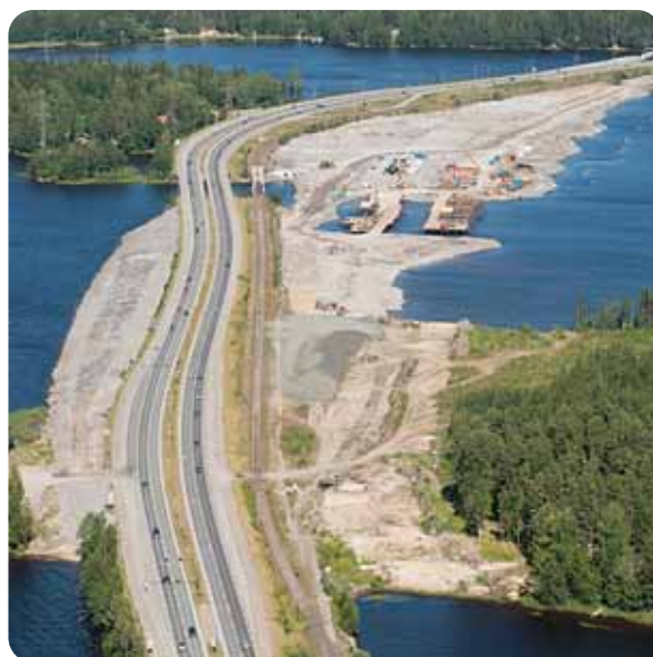
Vesipengertä rakennettiin reilut 10 hehtaaria
