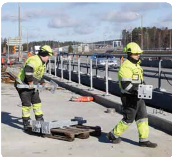
Läntisen sillan kaideasennusta kesällä 2014
