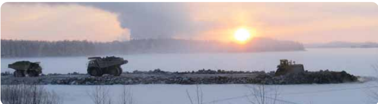
Patopenkereen rakentaminen käynnissä 2010
