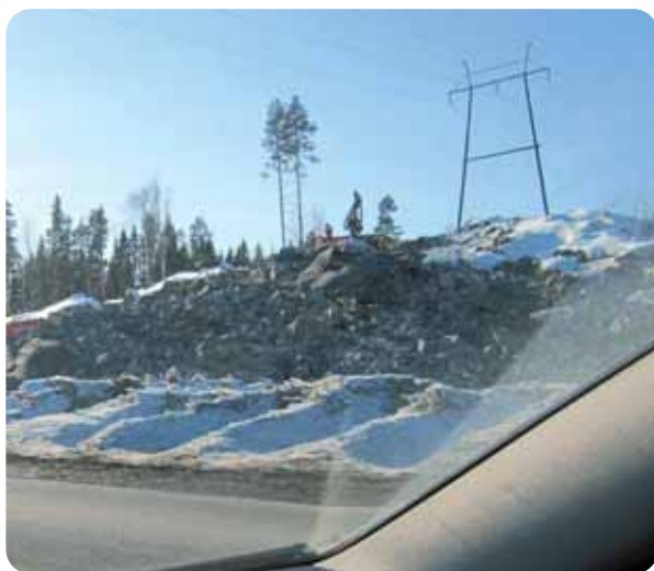
Siirretty Savon Sellun voimalinjapylvä.
