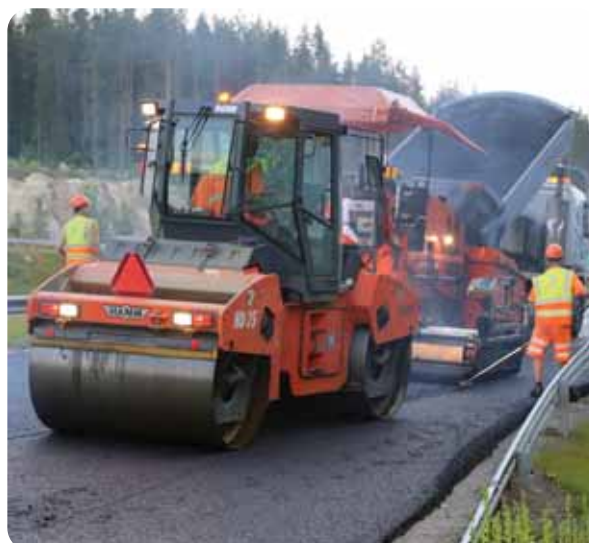
Ramppien päällystystöitä tehtiin yöllä 14.7.2014
