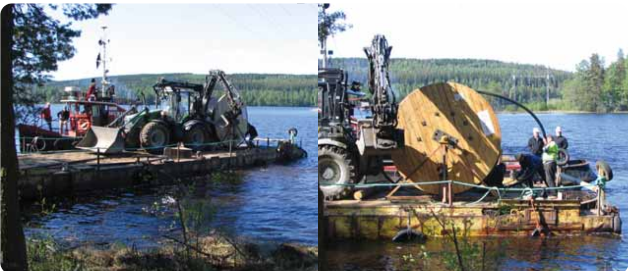
Sähkökaapelin laskua Päivärannan ja Tikkalansaaren välillä.
