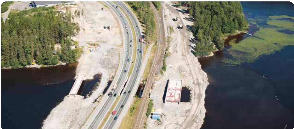
Valtatien ja rinnakkaistien rakentamista Sorsasalossa 23.7.2010
