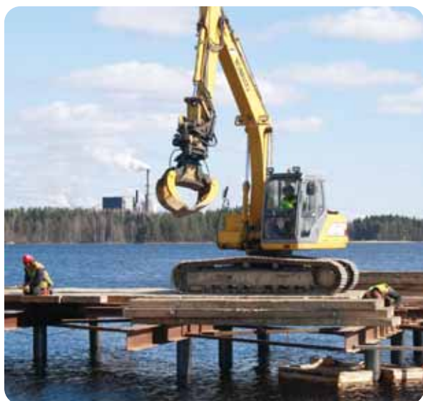
Työsillan rakentamista
