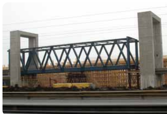
Ratasillan kehikko tunkattiin paikoilleen 20.4.2011
