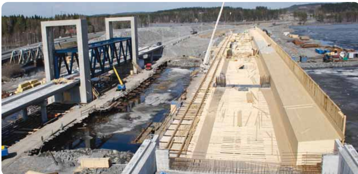
Tikkalansaaren rinnakkaistien silta rakenteilla 21.4.2011
