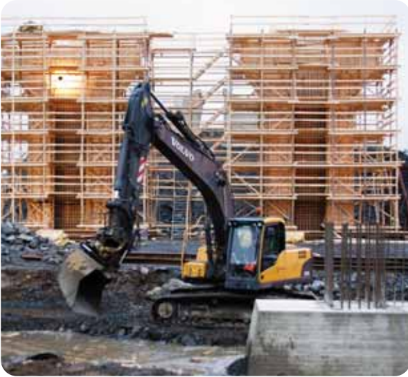
Tikkalansaaren moottoritiesillan pylonit ja rakennustelineviidakko
