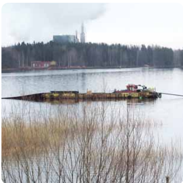
Suodatinkankaasta tehdyn suojaverhon asentamista, taustalla vedenottamo
