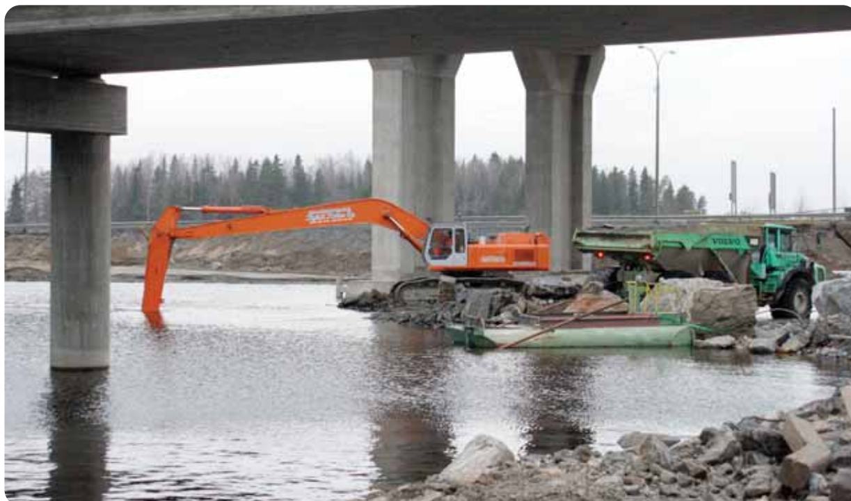
Laivaväylän ruoppausta Tikkalansaaren siltojen alla 27.11.2012
