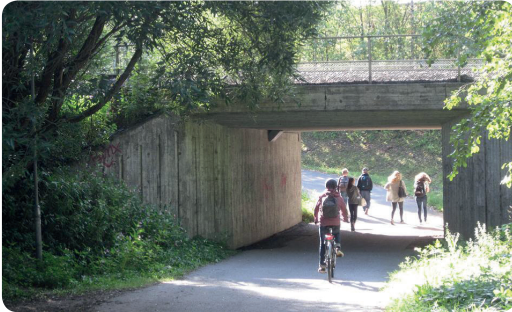
Kuva 8. Mäkinen alikulkutunneli Kuopiossa. Kuvauspäivä 18.8.2014.
