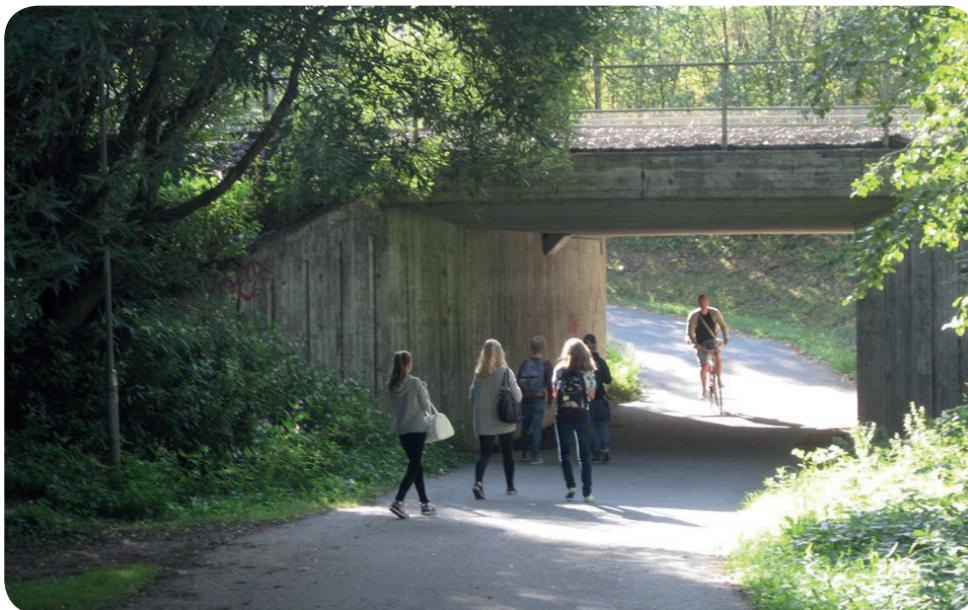
Kuva 7. Mäkinen alikulkutunneli Kuopiossa. Kuvauspäivä 18.8.2014.
